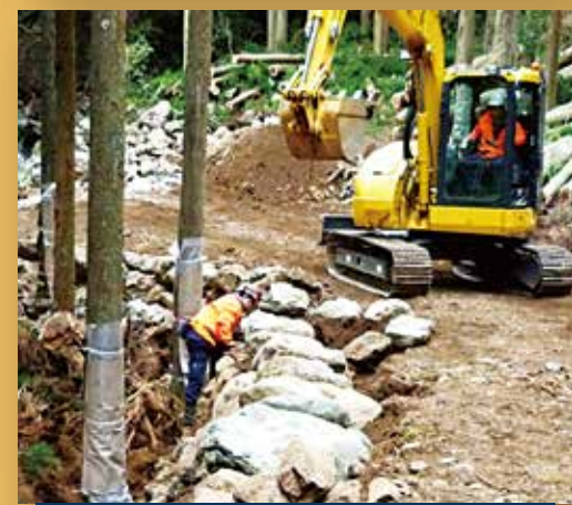
路肩を補強する石積工
