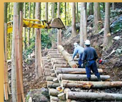
のり面を補強する丸太組工
