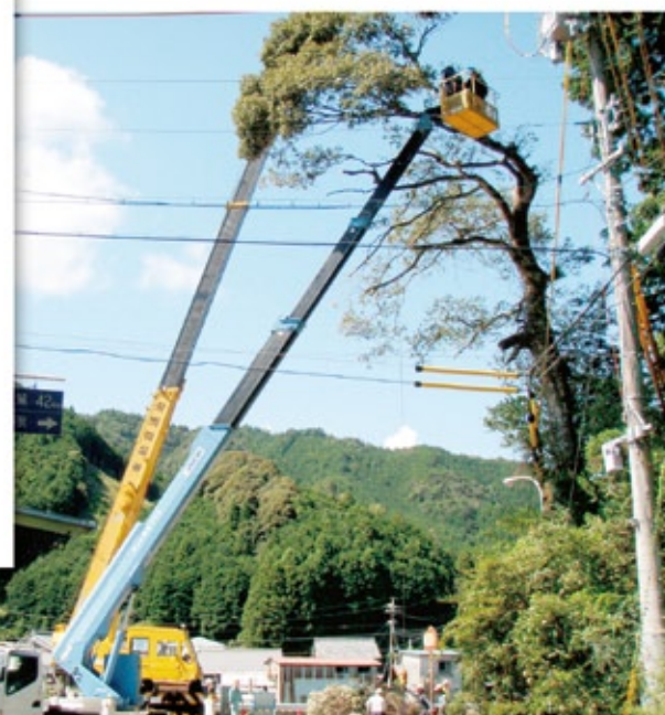
吊し伐り前の枝払い作業
