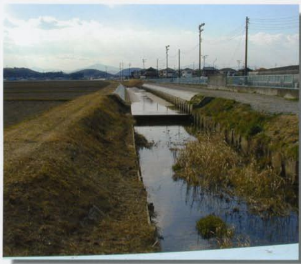
幹線排水路の老朽化、及び不当沈下部分をH15年度に整備 (国・県の補助により畜宮土地改良区が実施)
