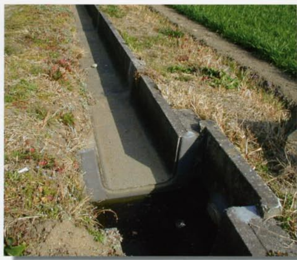
用水路の漏水防止のため、H15年度に整備 (国・県の補助により畜宮土地改良区が実施)
