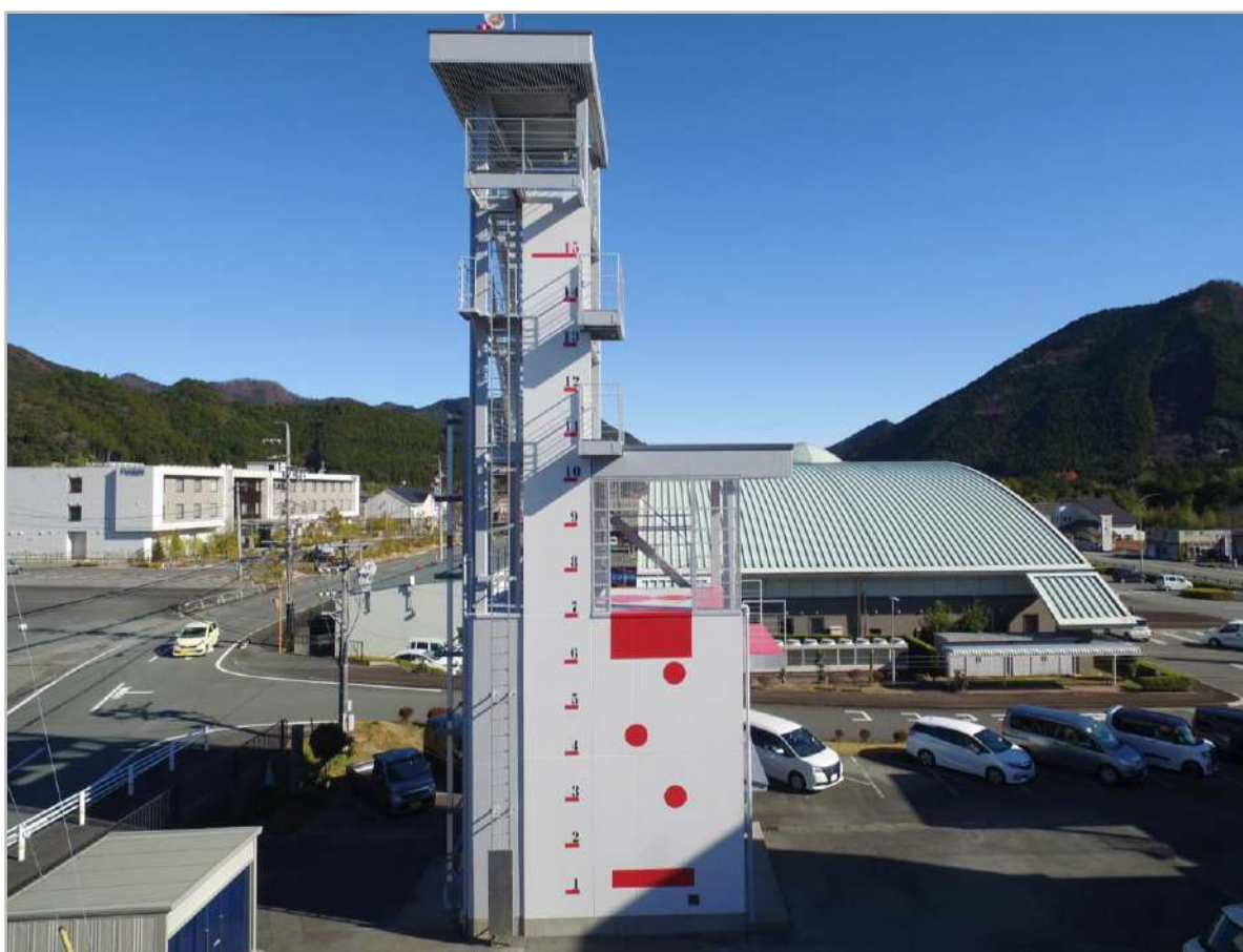
奥伊勢消防署 訓練塔改修工事（令和 3 年 1 2 月完了）
