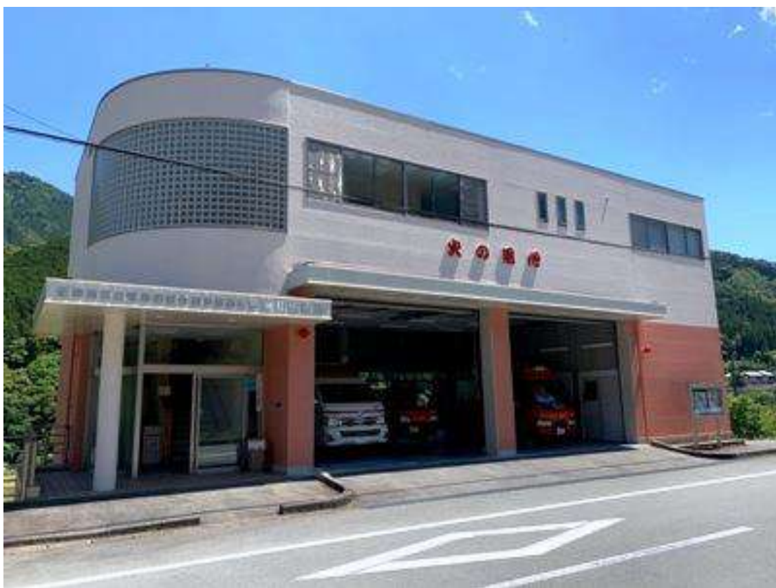
宮川出張所（令和元年9月庁舎改修工事完了）
