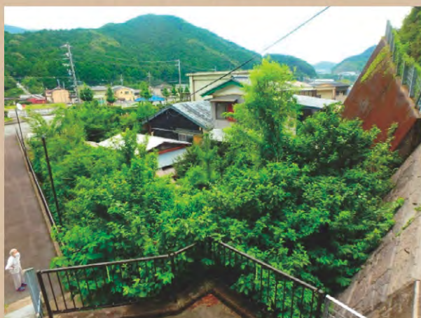
【庭木伐採】 着工前
