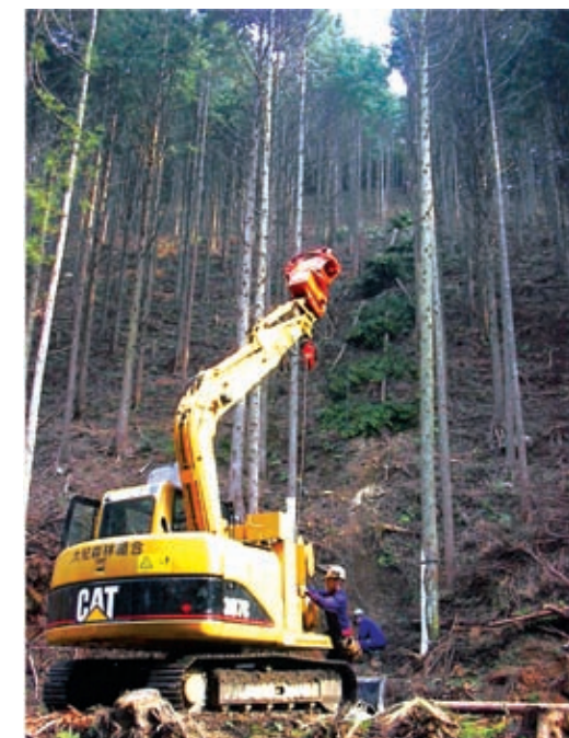
搬出作業中のスイングヤーダ
