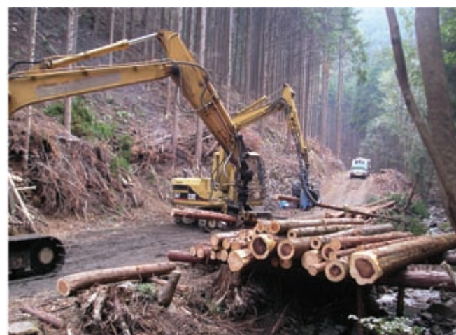
作業道の開設が必須である作業システム
